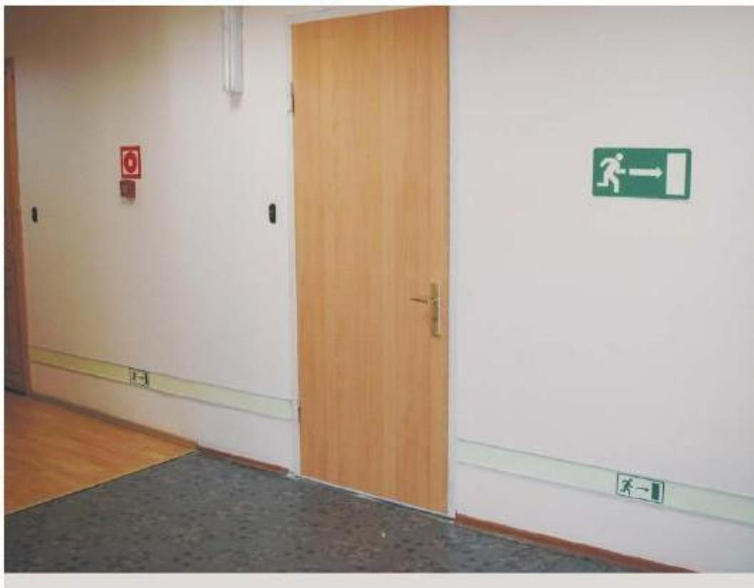
Рисунок А.8 - Вариант компоновки ФЭС
